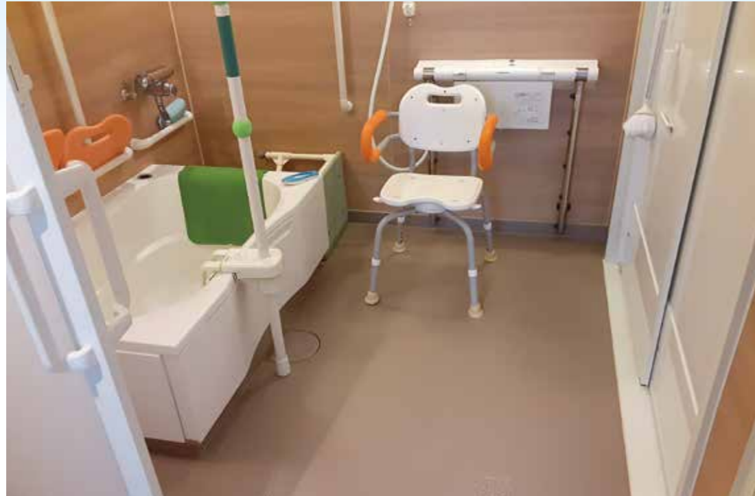
デイサービスお風呂場への設置事例です。 広い浴室空間に設置することで、今までどこにも掴まるところがなかった中央空間で支持物を作ることが出来ました。
