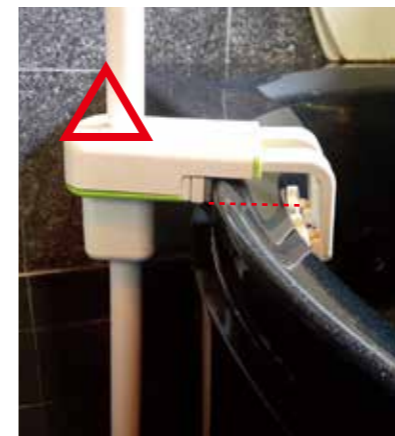
浴槽縁上部が傾斜している
