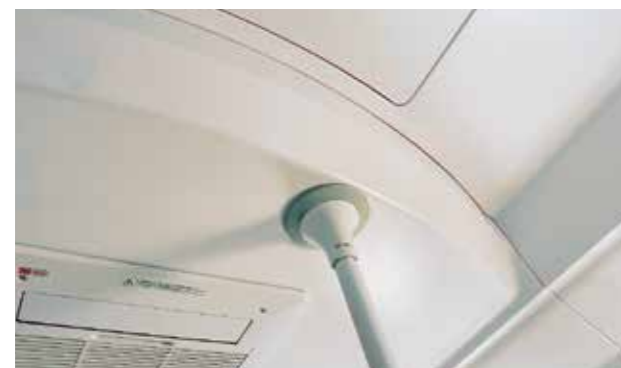
ドーム天井の傾斜のないフラットな部分
