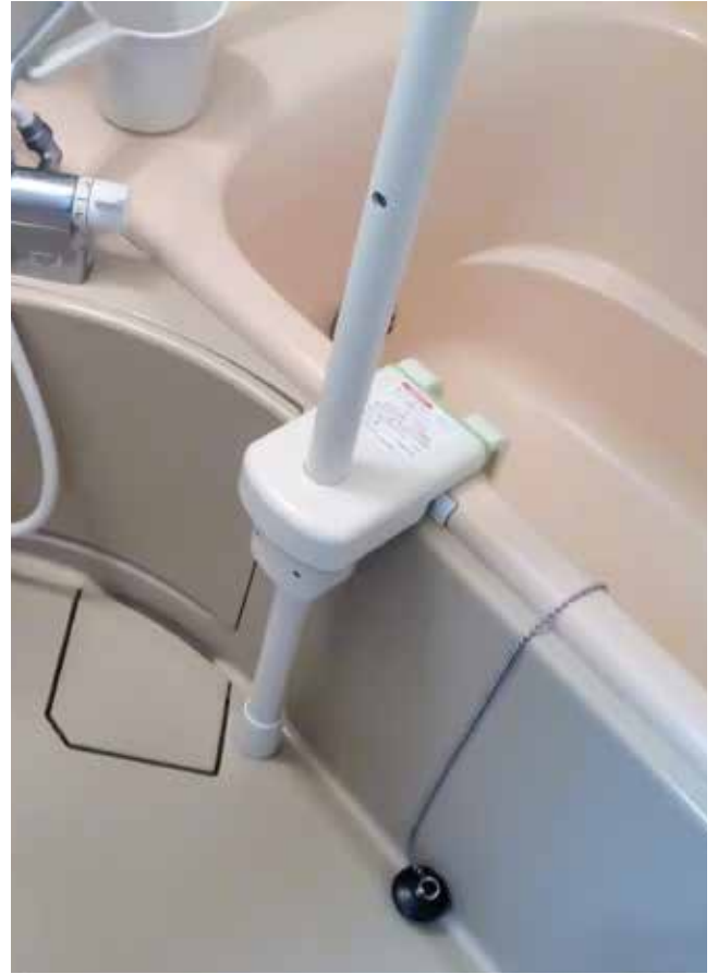
エプロン外段差（プラス段差）
